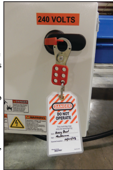
Figura 1-1: Ejemplo de un dispositivo de bloqueo/ etiquetado
